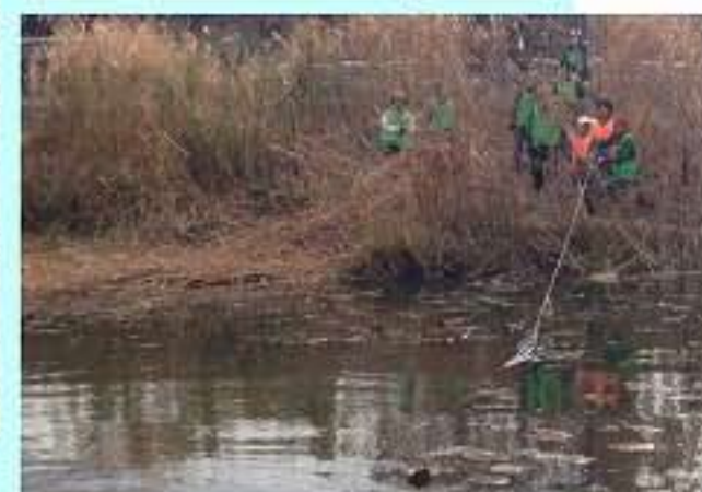
手順。全ての重りを取り外してから両端のロープを 引っ張った。シートの上に泥が溜まっており、かなり 重いため、片方ずつ交互に引いた。
