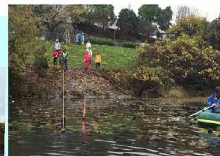
手順。まず全ての重りを外し、シートの片側にロープを 結びつけ、陸から地引き網の要領で一気に引き上げた。
