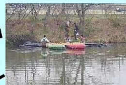
2. 設置場所に目印のポールを立てる
