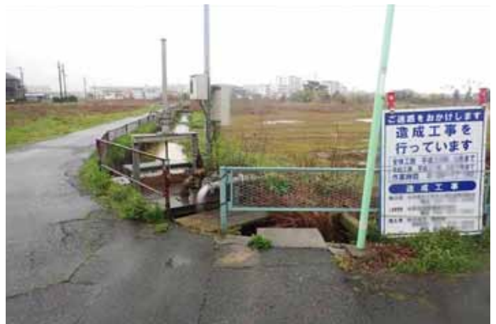
写真 3. カワバタモロコが生息する水路 (工事前)
