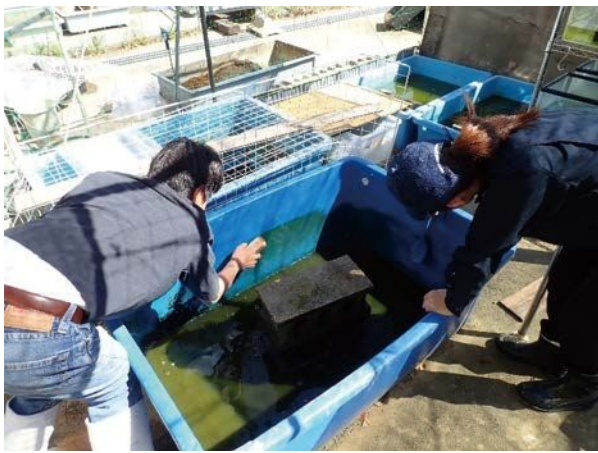
図3. 「カメハウス」内の飼育設備の修繕作業 (なごや生物多様性センター)
